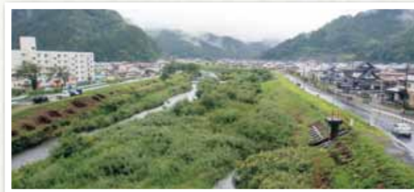
小釜川の掘削予定地
