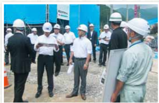
大ケ口地区に建設中の災害公営住宅にて（大槌町）
