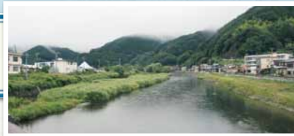
甲子川の掘削予定地
