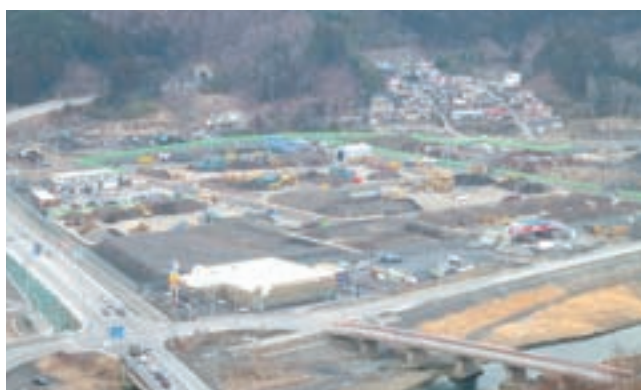
大槌町のがれき選別作業現場
